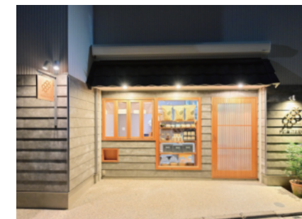
1階部分を強調した新店舗の外観
